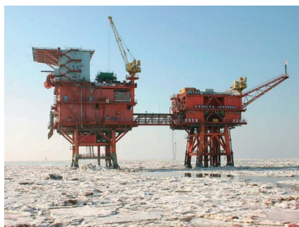
图2 JZ20-2MUQ 导管架平台 Fig.2 JZ20-2MUQ jacket platform
